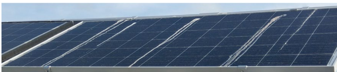
▲圖廿 候鳥棲息環境，可能有鳥糞堆積造成系統遮陰的問題
