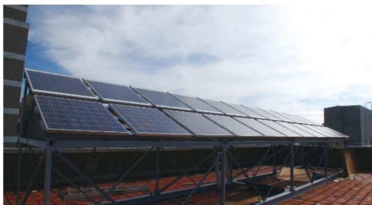
▲圖十五 完成太陽光電系統模組架設
