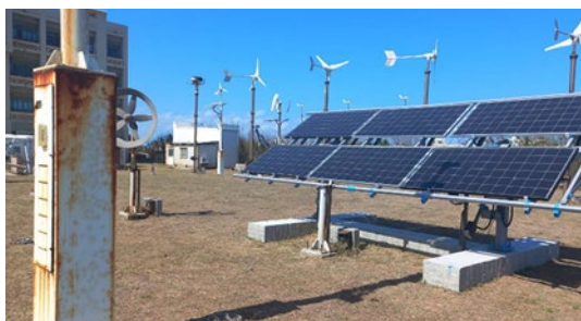
▲圖十一 風車柱遮陰下太陽光電模組之情形
