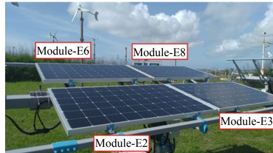
▲圖八 風車柱環境安裝
