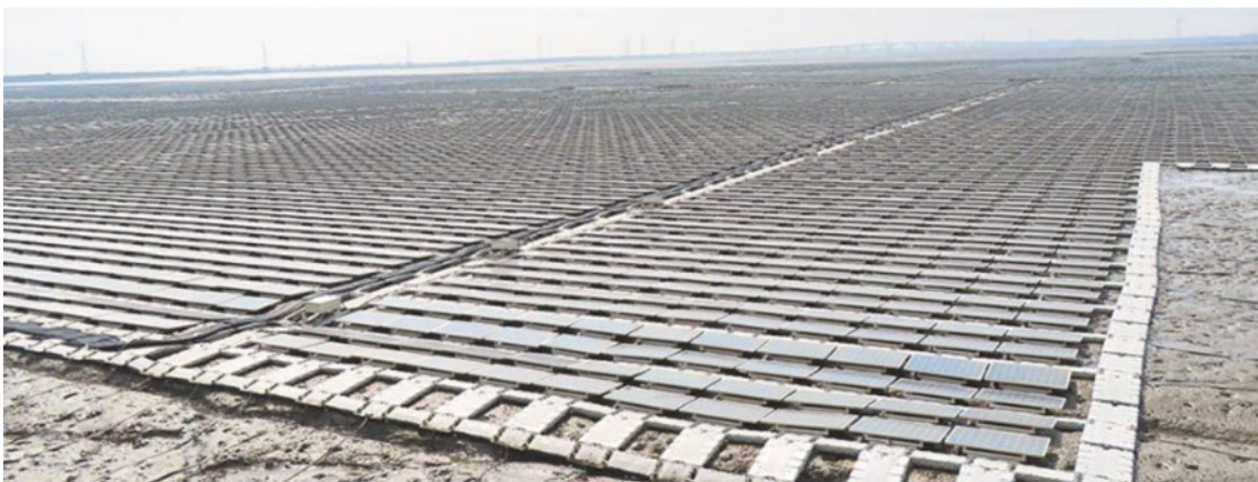
▲圖廿二 浮動型太陽光電系統在退潮時有可能緊貼泥灘地 (16)
