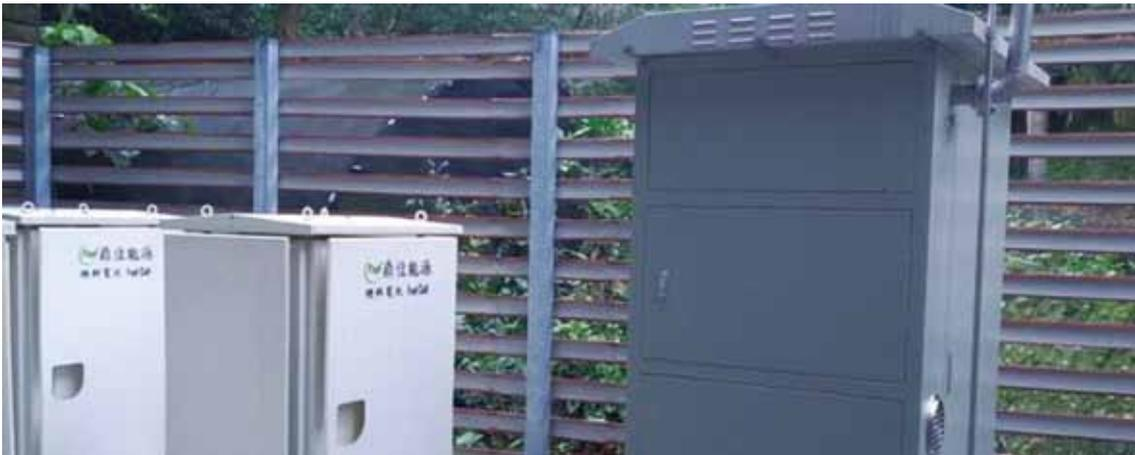
▲ 圖五 國立臺灣海洋大學高抗災基地台，左為5 kW燃料電池模組，右為20 Nm<sup>3</sup>甲醇重組產氫機
