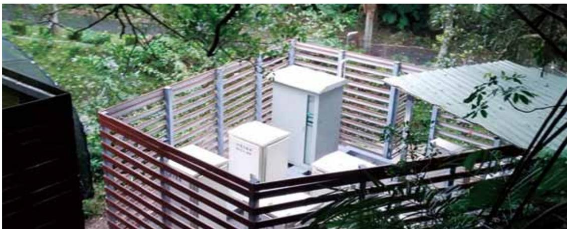
▲ 圖七 國立臺灣海洋大學高抗災基地台，20 kW甲醇重組燃料電池備用電力全景
