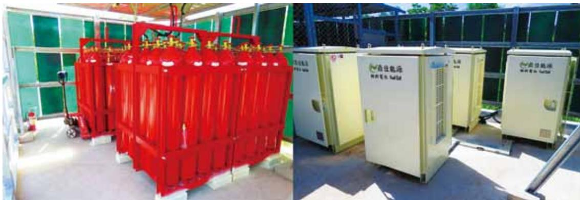
▲ 圖二 台東大學高防災基地台，26 kW燃料電池備用電力，罐裝氫氣
