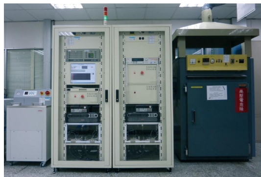
▲圖八 耐久性測試設備系統
