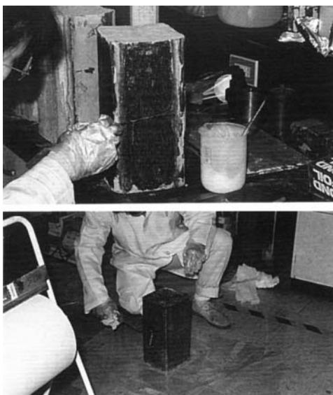
前工前表面處理（上），施工中（下）
